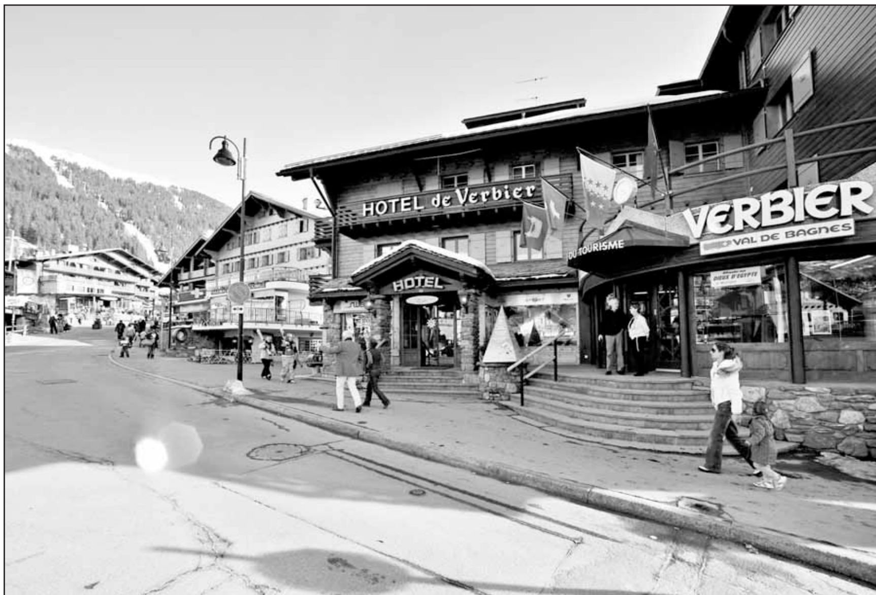
Entretien, rénovation et reconstruction du parc immobilier de Verbier, dont la valeur est évaluée à 4,4 milliards de francs, représentent déjà de nombreux postes de travail. HOFMANN
